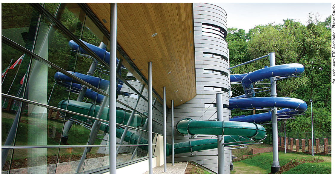
Boczna (wschodnia) elewacja hali basenów rekreacyjnych / The side-elevation (eastern) of the recreation pools hall
